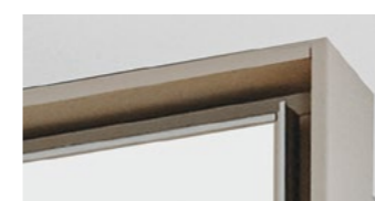
Passe-partout étroit sans éclairage
